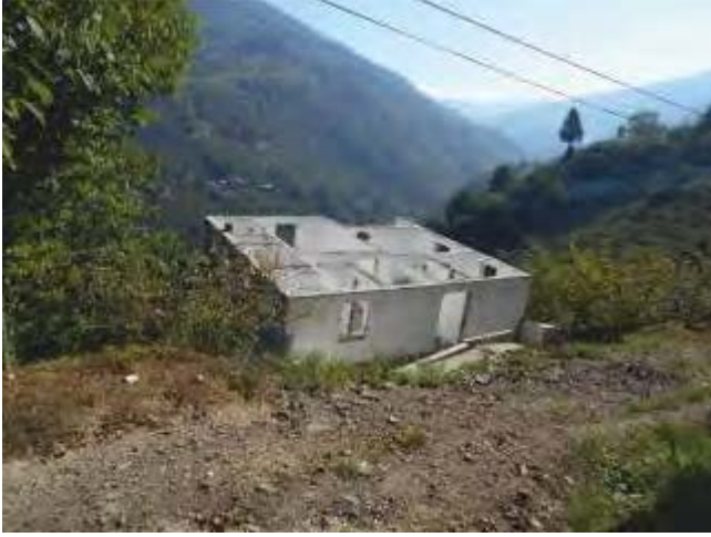
Resim 75. Aksu Mahallesi Bina Yıkımı
