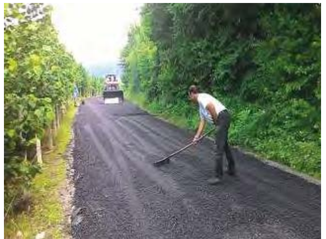
Resim 59. Bıçkı Atik Mah. Asfalt Yama Çalışması
