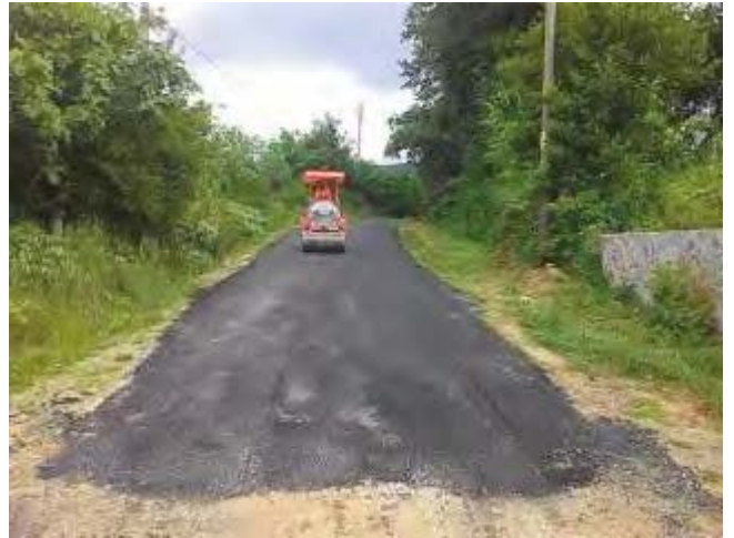
Resim 57. Güldibi Mahallesi Asfalt Yama Çalışması
