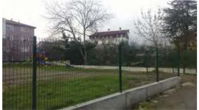
Resim 34. Başpınar Mahallesi Bostancı Parkı Çevre Duvarının Yenilenmesi
