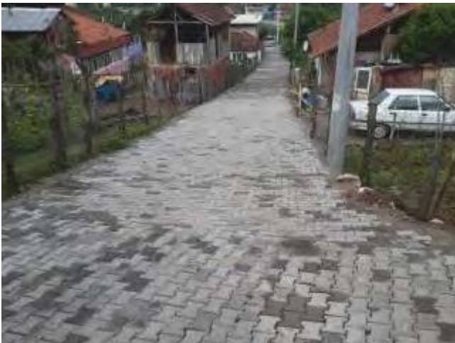
Resim 62. Yeşilyurt Mah. Kilitli Parke Yol Çalışması
