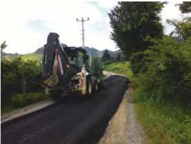
Resim 58. Bıçkı Atik Mah. Asfalt Yama Çalışması
