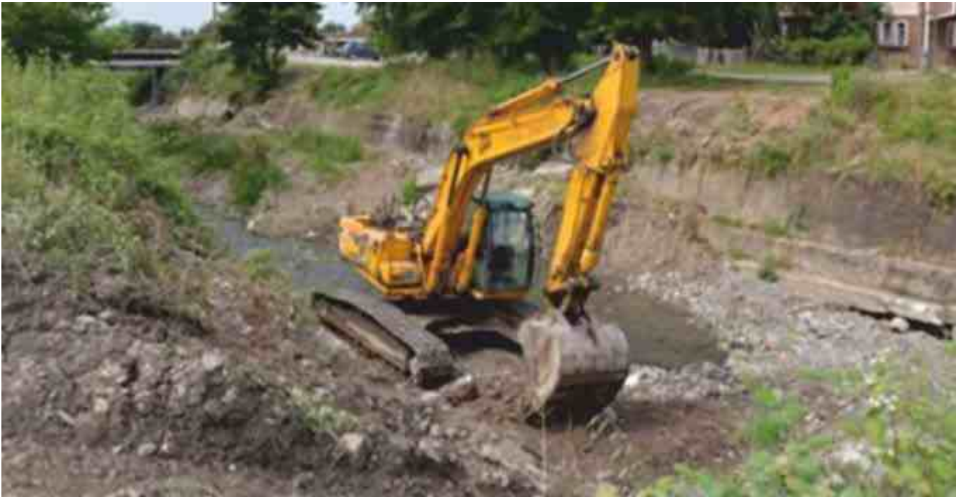
Resim 86. Uludere Rekreasyon 2. Etap Çalışmaları
