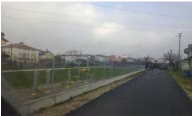
Resim 35. Başpınar Mahallesi Bostancı Parkı Çevre Duvarının Yenilenmesi
