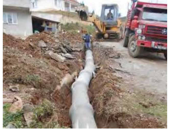
Resim 67. Bayraktepe Mahallesi Yağmursuyu Kanalı Çalışması
