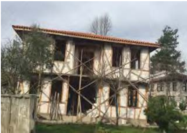
Resim 159. Restorasyonu Devam Eden 72 Ada 28 Parsel
