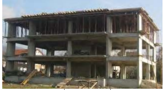
Resim 146. Yapı İnşaatını Bina İskelet Seviyesi
