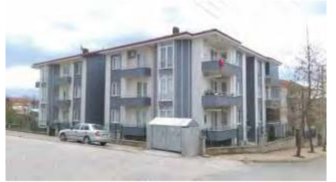
Resim 150. İskan Belgesi Tamamlanmış Bina Örneği
