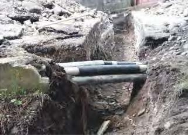
Resim 70. Çağlayan Mahallesi Yağmursuyu Kanalı Bakım Çalışması
