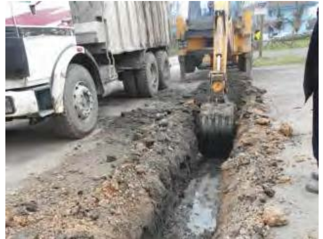
Resim 73. Yayalar Mahallesi Yağmursuyu Kanalı Bakım Çalışması
