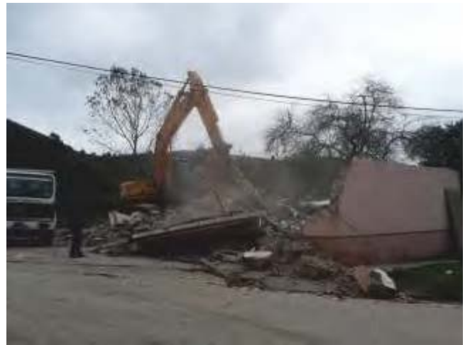
Resim 79. Dereköy Mahallesi Bina Yıkımı
