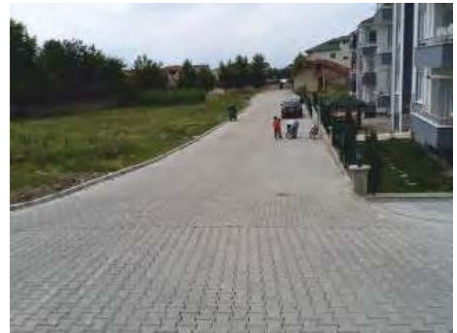
Resim 63. Sarıdede Mah. Kilitli Parke Yol Çalışması
