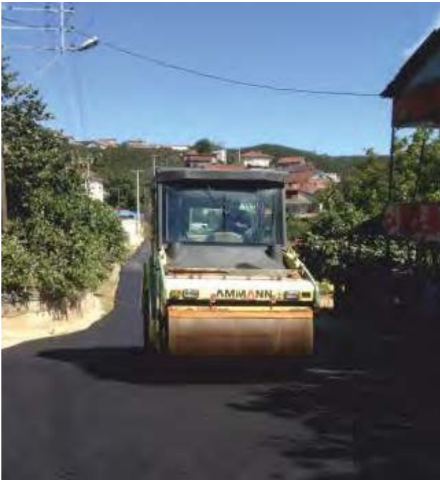
Resim 53. Kocatöngel Mahallesi Asfalt Çalışması
