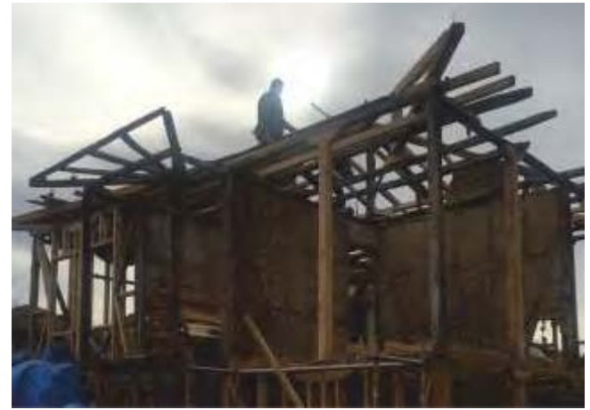
Resim 160. Restorasyonu Devam Eden 22 Ada 83 Parsel
