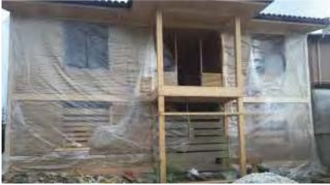
Resim 158. Restorasyonu Devam Eden 55 Ada 32 Parsel
