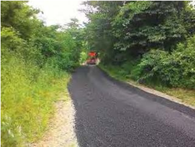
Resim 56. Güldibi Mahallesi Asfalt Yama Çalışması
