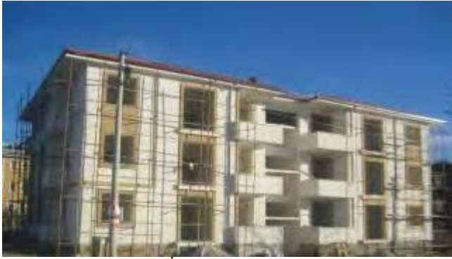
Resim 147. Yapı İnşaatının Çatı Tesisat Seviyesi
