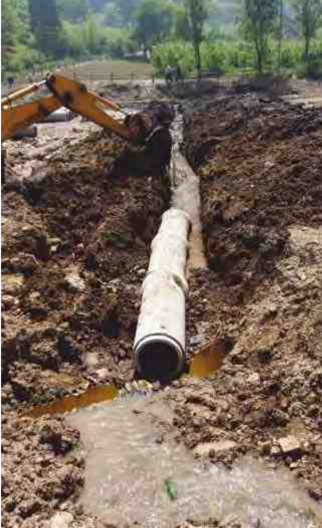
Resim 68. Bakacak Mahallesi Yağmursuyu Kanalı Çalışması
