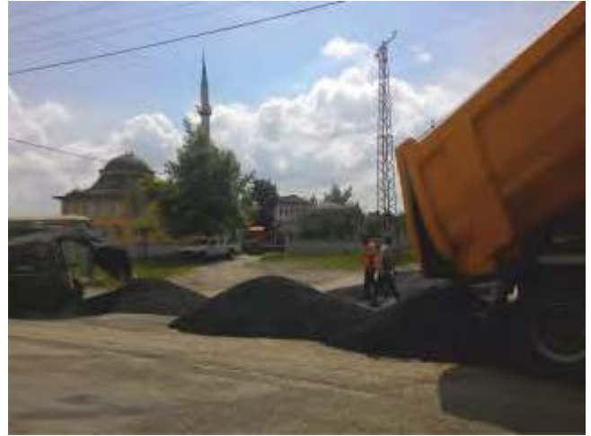
Resim 81. Aşağı Çalica Mahallesi Asfalt Serimi
