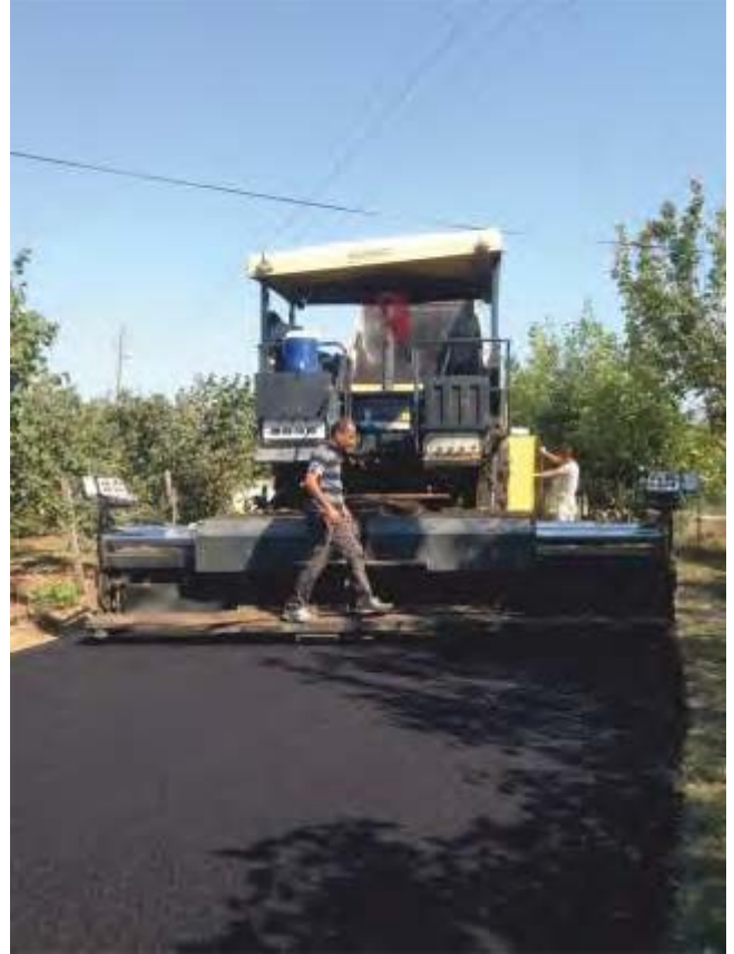
Resim 52. Büyükdere Mahallesi Asfalt Çalışması
