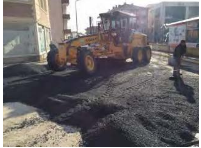
Resim 80. Yeni Mahalle Asfalt Serimi
