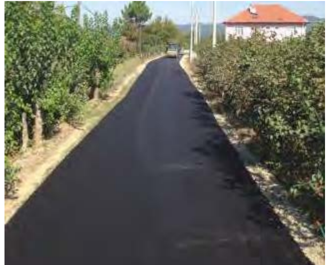
Resim 83. Büyükdere Mahallesi Asfalt Serimi
