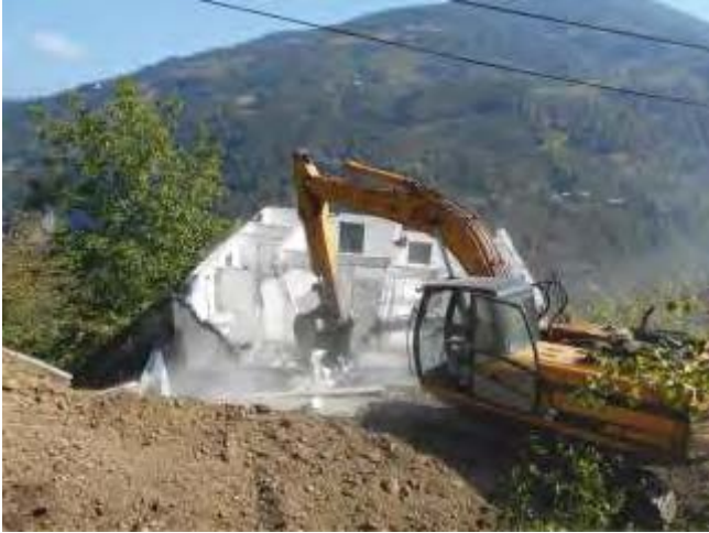
Resim 76. Aksu Mahallesi Bina Yıkımı
