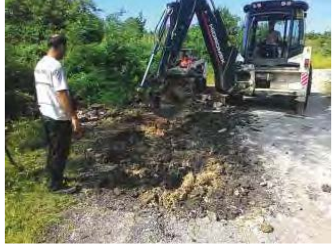
Resim 55. Güldibi Mahallesi Asfalt Yama Çalışması
