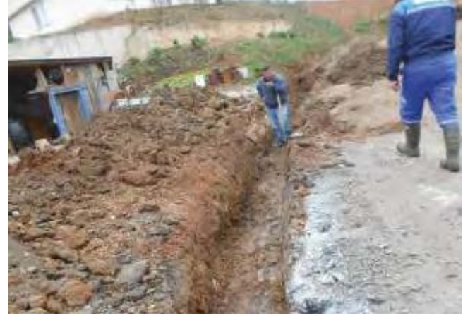
Resim 66. Bayraktepe Mahallesi Yağmursuyu Kanalı Çalışması
