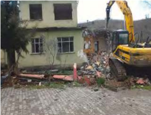
Resim 78. Dereköy Mahallesi Bina Yıkımı
