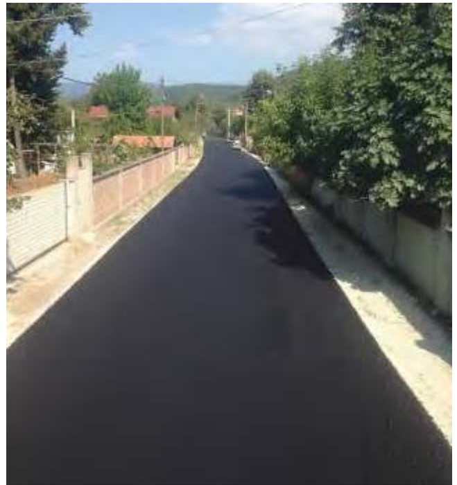
Resim 54. Tonyalı Mahallesi Asfalt Çalışması
