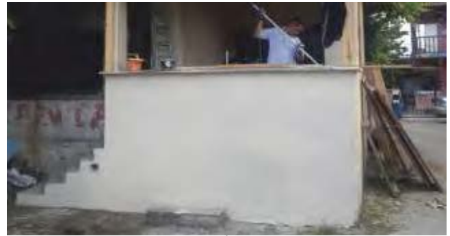
Resim 74. Tespit Edilen İhtiyaç Sahibi Ev Onarımı
