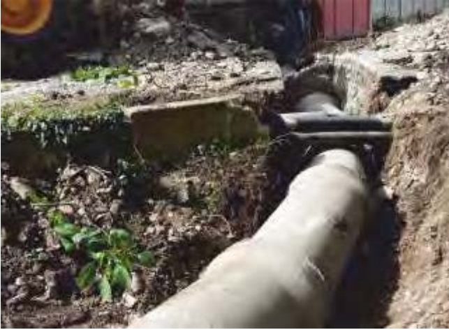
Resim 71. Çağlayan Mahallesi Yağmursuyu Kanalı Bakım Çalışması
