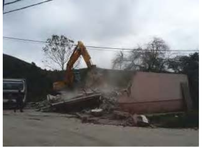
Resim 77. Dereköy Mahallesi Bina Yıkımı
