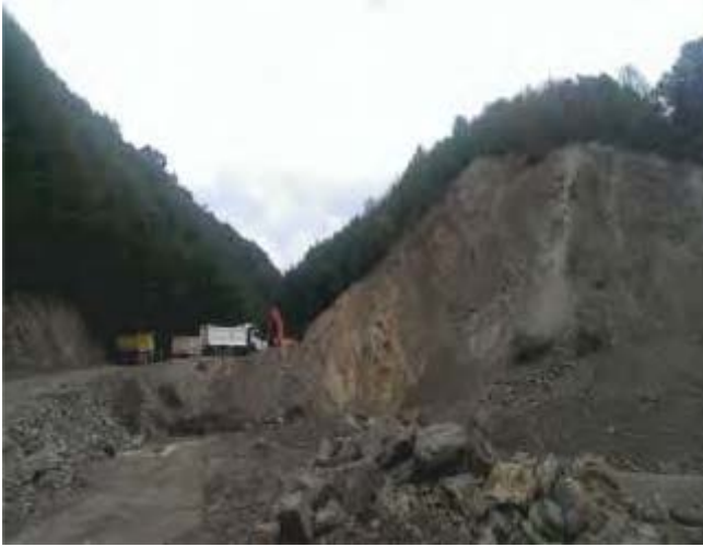
Resim 185. Kazımiye Taş Ocağı Çalışmaları
