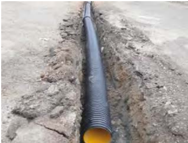
Resim 72. Yayalar Mahallesi Yağmursuyu Kanalı Bakım Çalışması
