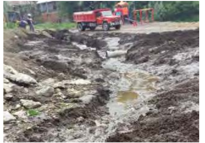
Resim 69. Bakacak Mahallesi Yağmursuyu Kanalı Çalışması
