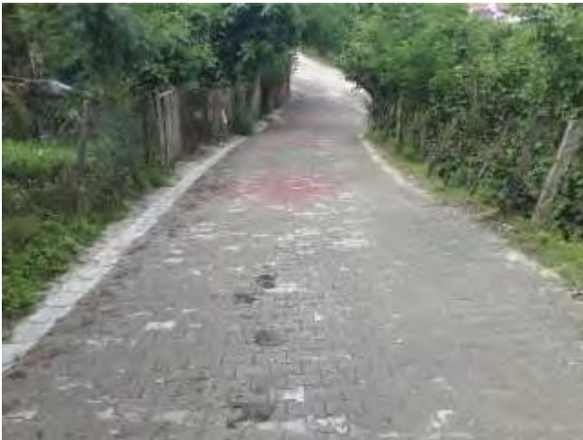
Resim 61. Yeşilyurt Mah. Kilitli Parke Yol Çalışması
