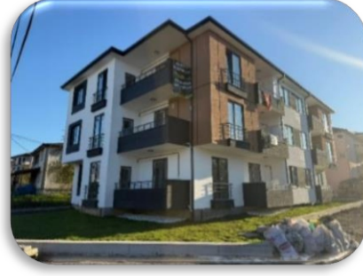
Yapı Kontrol Seviye Tespit (%100 Seviye)
