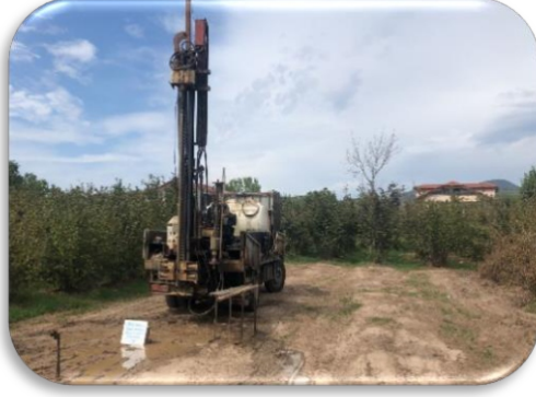
Zemin Etüd Çalışması
