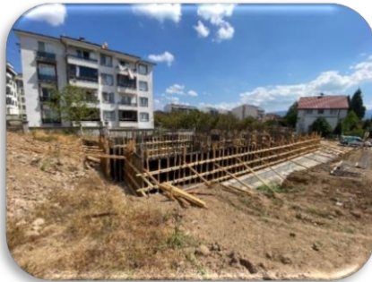
Yapı Kontrol Seviye Tespit (%20 Seviye)
