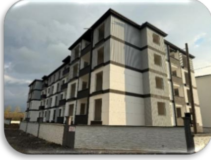
Yapı Kontrol Seviye Tespit (%80 Seviye)
