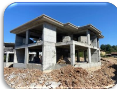
Yapı Kontrol Seviye Tespit (%60 Seviye)
