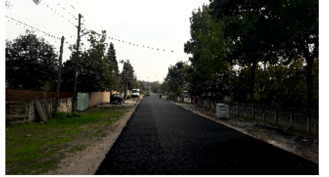
Resim 17. Hacıkişla Mahallesi Asfaltma Çalışması
