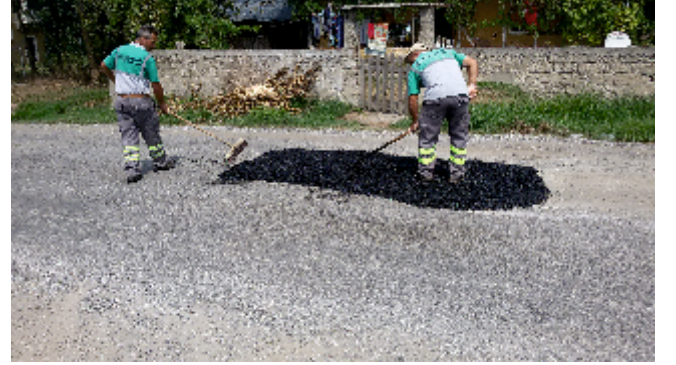
Resim 21. Bakımı Yapılan Yol Çalışması
