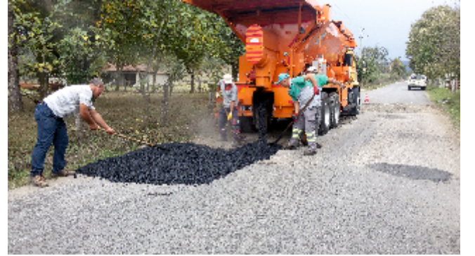
Resim 23. Bakımı Yapılan Yol Çalışması
