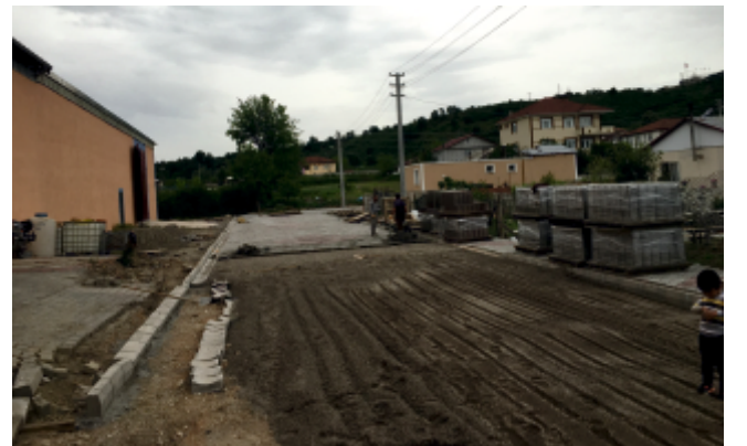
Resim 24. Kilit Parke ile Yapılan Yol Çalışması
