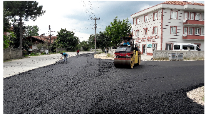
Resim 19. Rasimpaşa Mahallesi Asfaltma Çalışması
