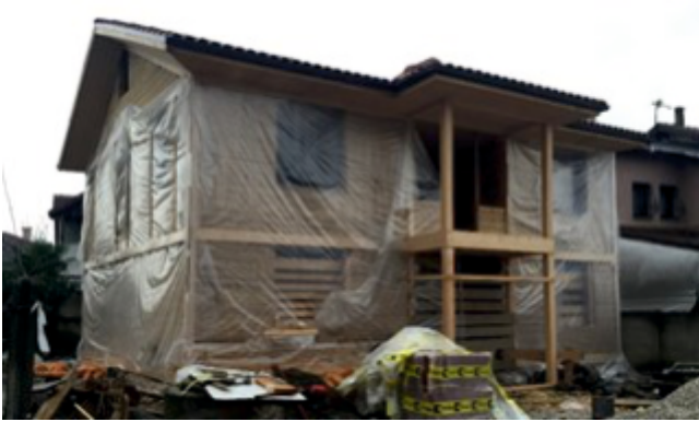
Resim 125. Restorasyonu devam eden 55 ada 32 parsel
