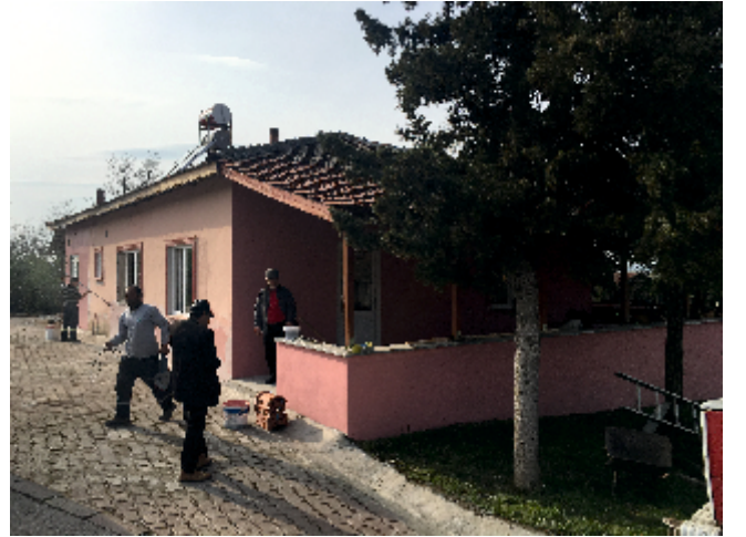
Resim 99. Karatoprak Mahalle Konağı Tadilat İşİ
