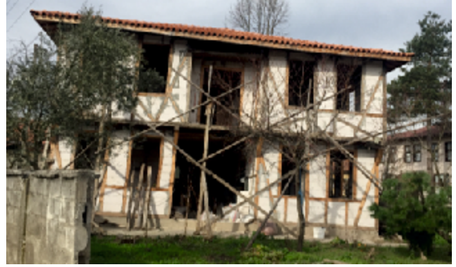
Resim 126. Restorasyonu devam eden 72 ada 28 parsel
