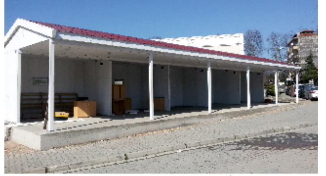
Resim 32. Köfteciler Prefabrik Yapım İş Çalışması
