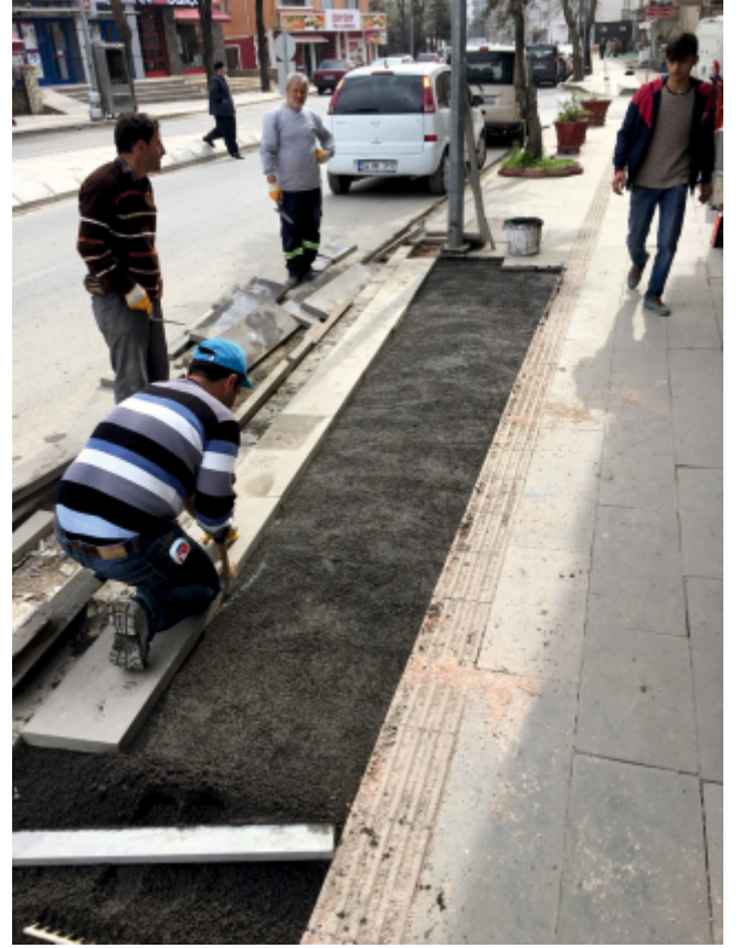
Resim 27. Kaldırım Yenileme Çalışması Örneği
