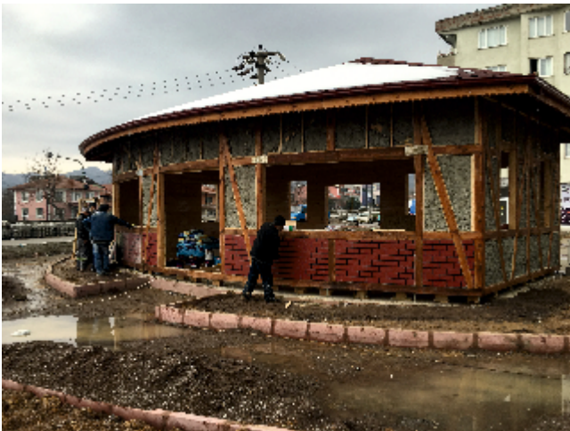
Resim 32. Kule Park Yapım Çalışması
