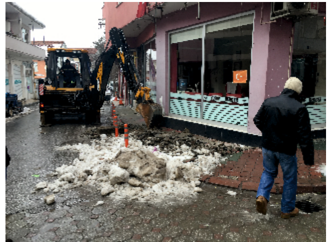
Resim 28. Kaldırım Bakım Çalışması Örneği
