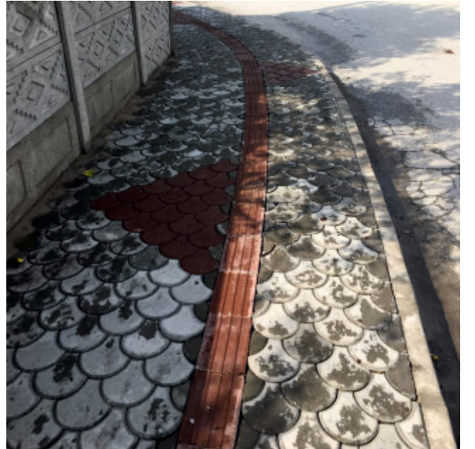
Resim 26. Yeni Yapılan Kaldırım Çalışması Örneği
