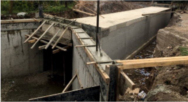
Resim 36. Menfez Yapım İşİ
