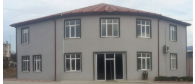
Resim 93. Garaj İdari Bina Yapım İşİ
