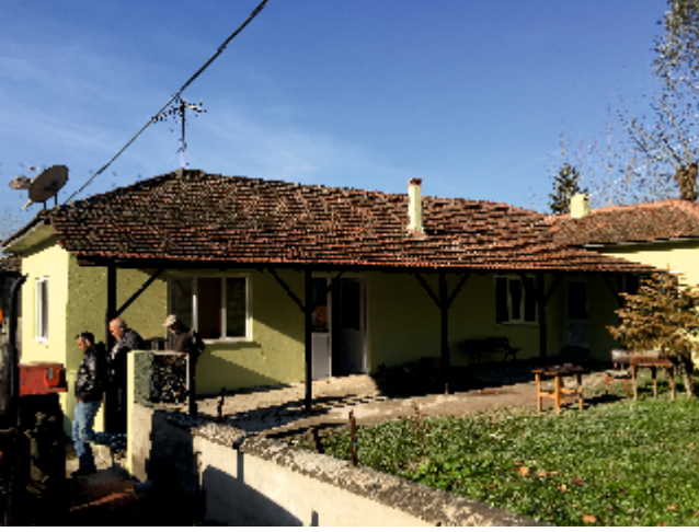
Resim 96. Akarca Mahalle Konağı Tadilat İşİ
