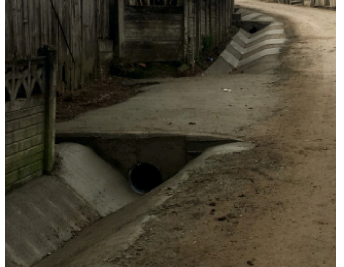
Resim 29. Oluşturulan Yağmursuyu Kanalı Çalışması Örneği
