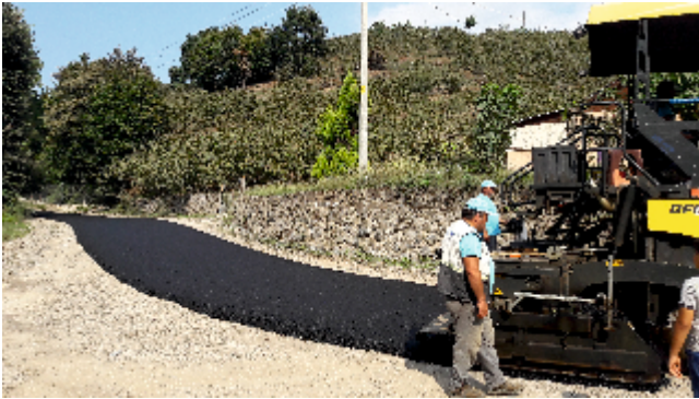
Resim 18. Kocaahmetler Mahallesi Asfaltma Çalışması
