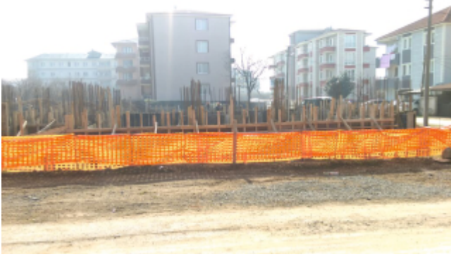
Resim 134. Temel Seviye Hakediş Aşaması
