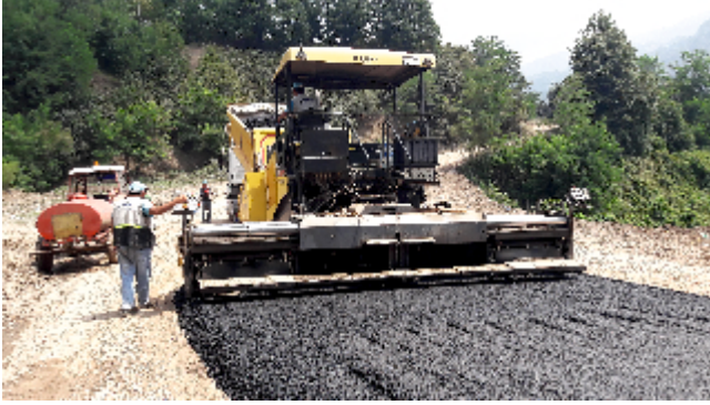
Resim 16. Çamlıca Mahallesi Asfaltma Çalışması
