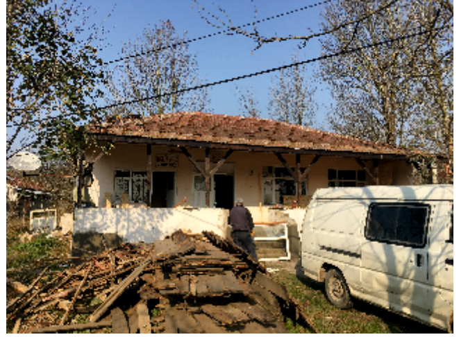
Resim 97. Hallaç Mahalle Konağı Tadilat İşİ
