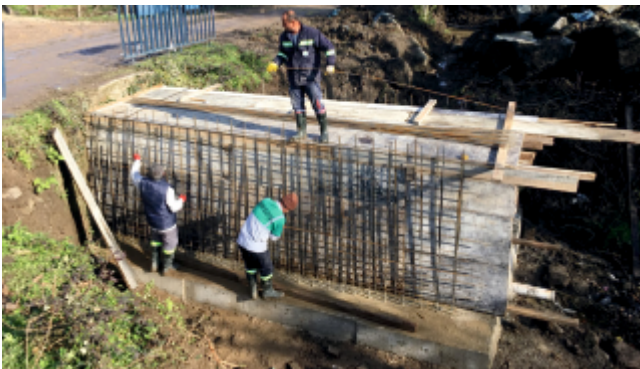
Resim 37. Menfez Yapım İşİ
