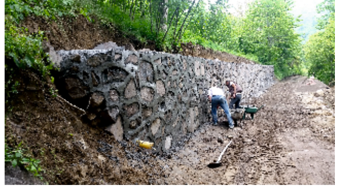
Resim 38. Taş Duvar Yapım İşİ
