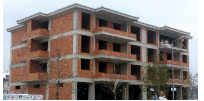
Resim 136. Çatı Tesisat Hakediş Aşaması
