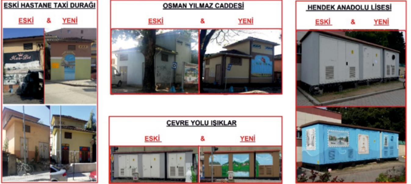
Resim 147. Hendek İlçesi Dâhilindeki Alanlarda Bulunan Trafo Binalarına Estetik Görünüm Kazandırılması Projesi
