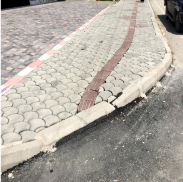
Resim 25. Yeni Yapılan Kaldırım Çalışması Örneği
