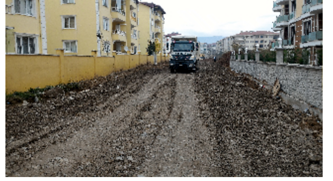
Resim 20. Yol Açım Çalışması
