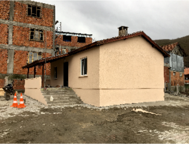
Resim 98. Dereköy Mahalle Konağı Tadilat İşİ
